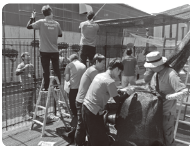
▲ネット張替えの様子
