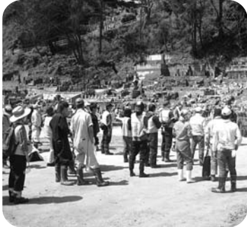
▲お盆を迎えられるようにお墓の泥、ガレキ撤去作業
