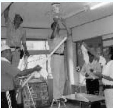
▲施設での照明取り付けの様子
